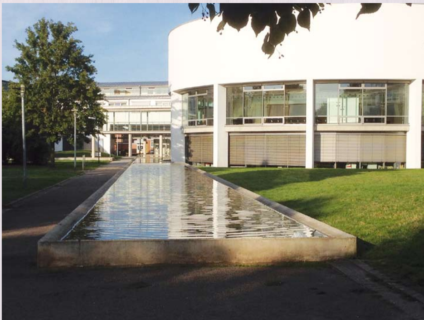
Das 1998 erbaute Kreishaus in Vechta (Von Corradox - Eigenes Werk, CC BY-SA 4.0, https://commons.wikimedia.org/w/index.php?curid=81938325 )
