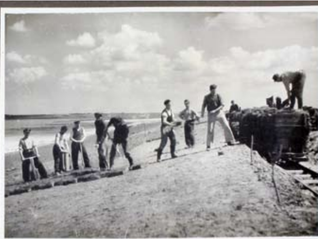
Die Außenböschung wird mit Rasenplatten (Soden) bedeckt.
